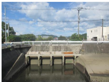
かつての排水口。現在周囲はエコパークとして整備
